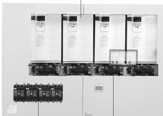
漏電しゃ断器
