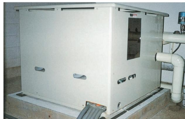
高架水槽からの給水管をそのまま使用する場合のリニューアルに自治体の施工条件に基づき、受水槽と高架水槽を撤去する直結増圧方式ではなく、受水槽のみ撤去し、高架水槽併用方式の直結増圧給水方式を採用。
