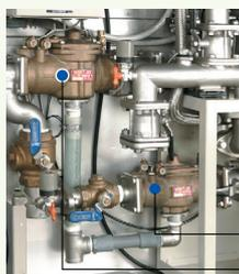
パッケージ内に逆流防止装置を2個装備し、常時は並列で給水し、点検時等は片側で給水が可能のため、断水することなく逆流防止装置の点検が可能です。(逆流防止装置同口径品もあります。)
