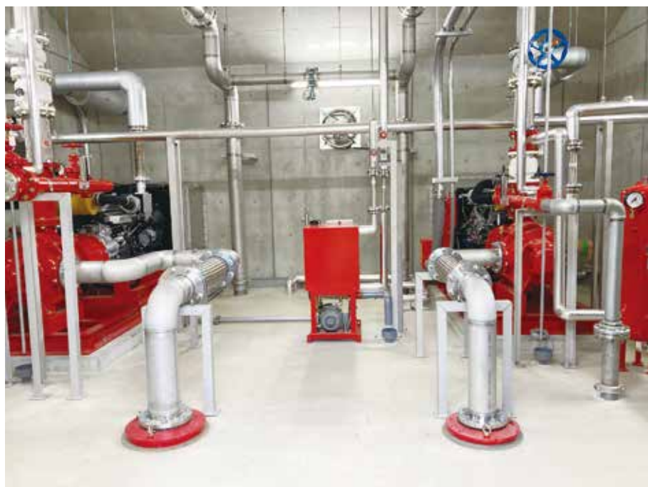
消火ポンプ(KTY-ET形)・スプリンクラー補助加圧ポンプユニット(DPK2形)
