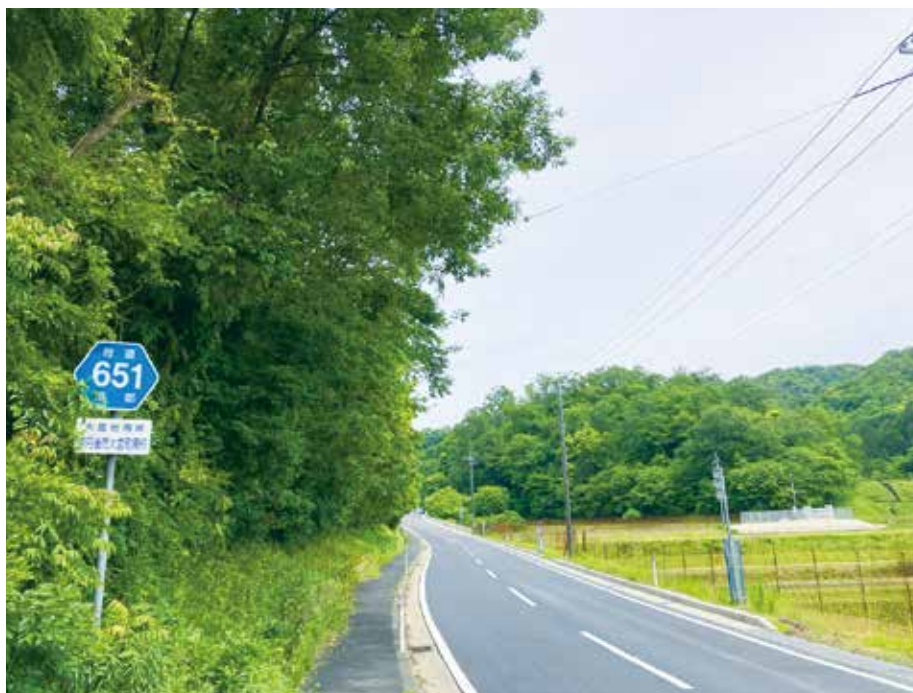
京都府道651号 大宮岩滝線の様子。車道に散水し、積雪を防止する。
