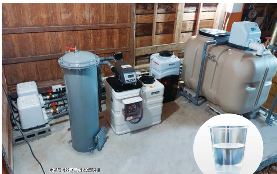
水処理機器ユニット設置現場
