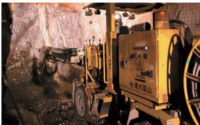
穿孔機で爆薬を装填する穴を開ける作業
