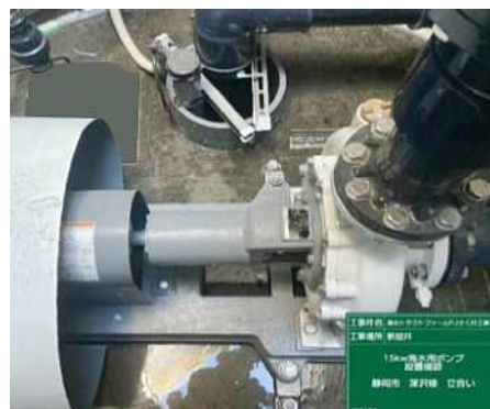
GEZ形ポンプ設置
