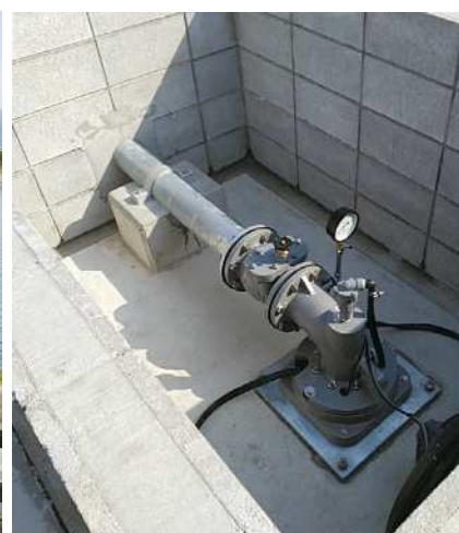
ポンプ設置場所②
