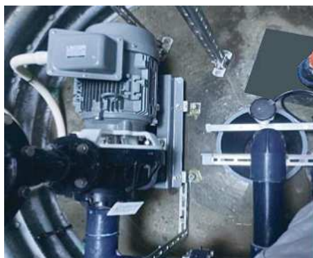
GSP4形ポンプ設置
