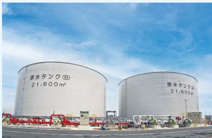
左側:KTY2006A2M132(2台)・制御盤(1面) 右側:T2006BX2ME132(3台)・制御盤(4面)
