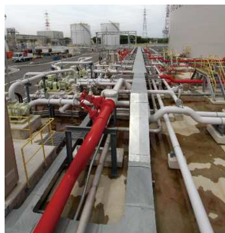
ポンプ設置全体風景
