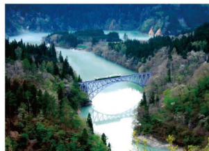
Photo:第一只見川橋梁を渡る列車（JR只見線）
