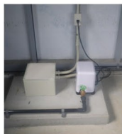
水中ポンプ制御ユニット設置
