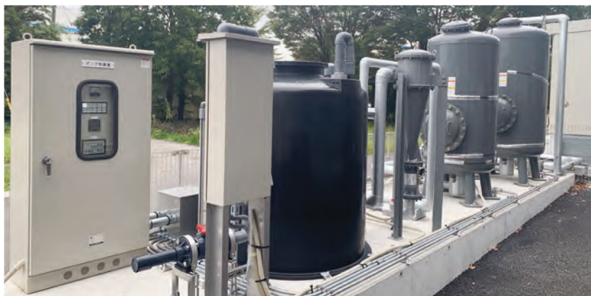
井戸水処理装置設置
