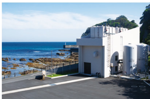
取水ポンプ棟
