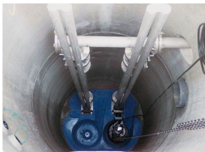
予旋回槽とBUM形(据付工事中)
