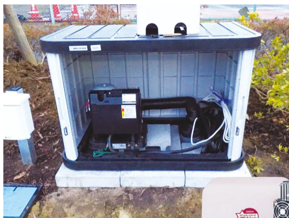
UFL2形設置(試運転のためカバーを開けた状態)
