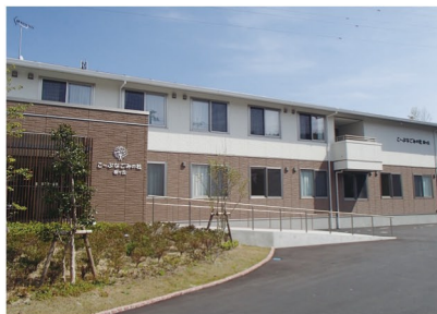
こ〜ぶなごみの杜桜ヶ丘の外観
