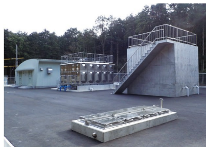
島原市水道課 立野浄水場 全景
