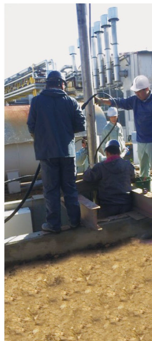
井戸へ設置の様子
