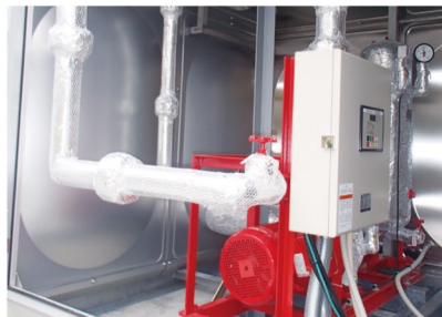
ステンレス消火水槽内部 消火ポンプユニット
