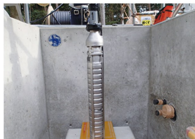
US2ステンレス製深井戸水中ポンプ設置
