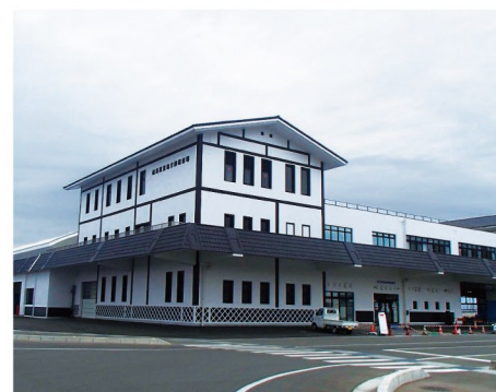
原釜漁港外観
