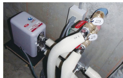
パイプシャフトへの設置
